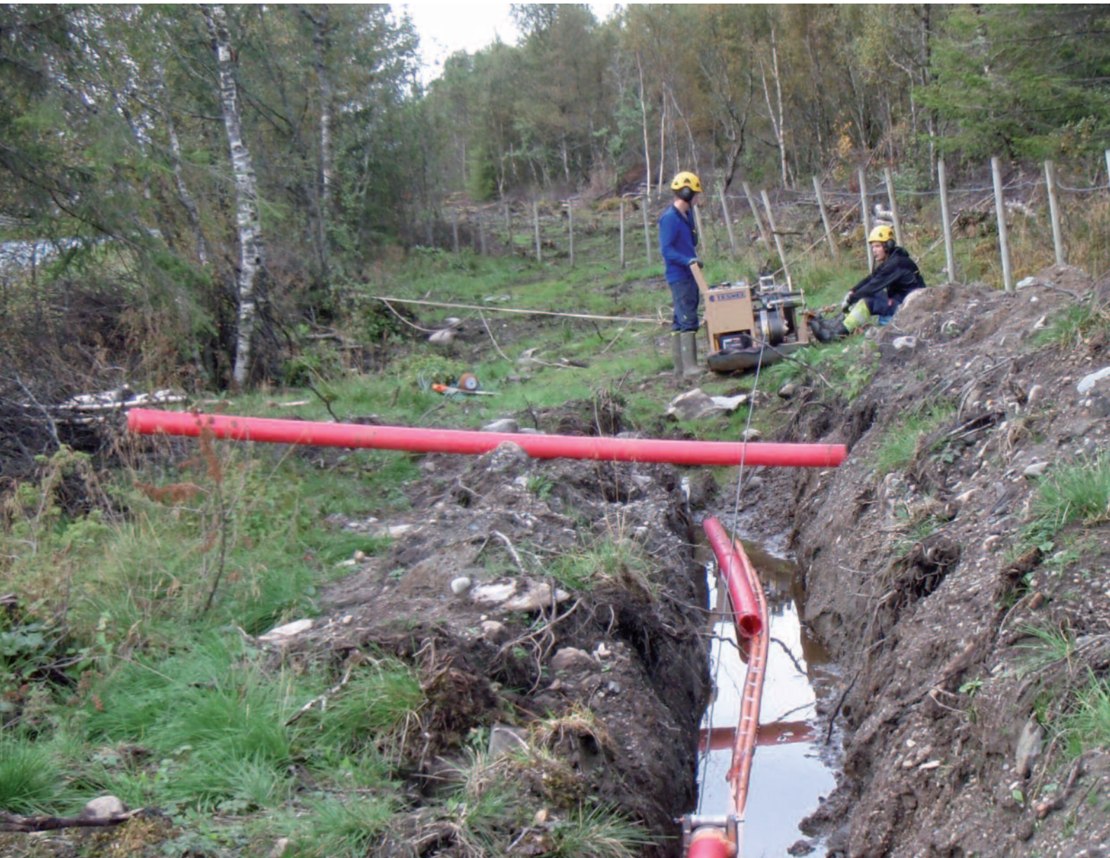
Nord-Salten Kraft er i full gang med å oppgradere strømmettet på Engeløya i Steigen.
