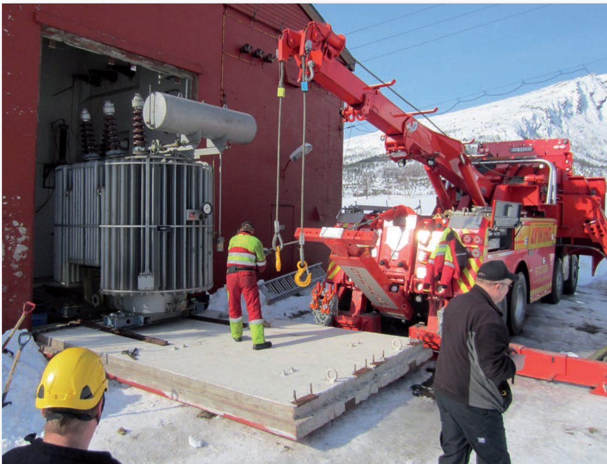
Demontering av Trafo1 på Skjelvareid.
