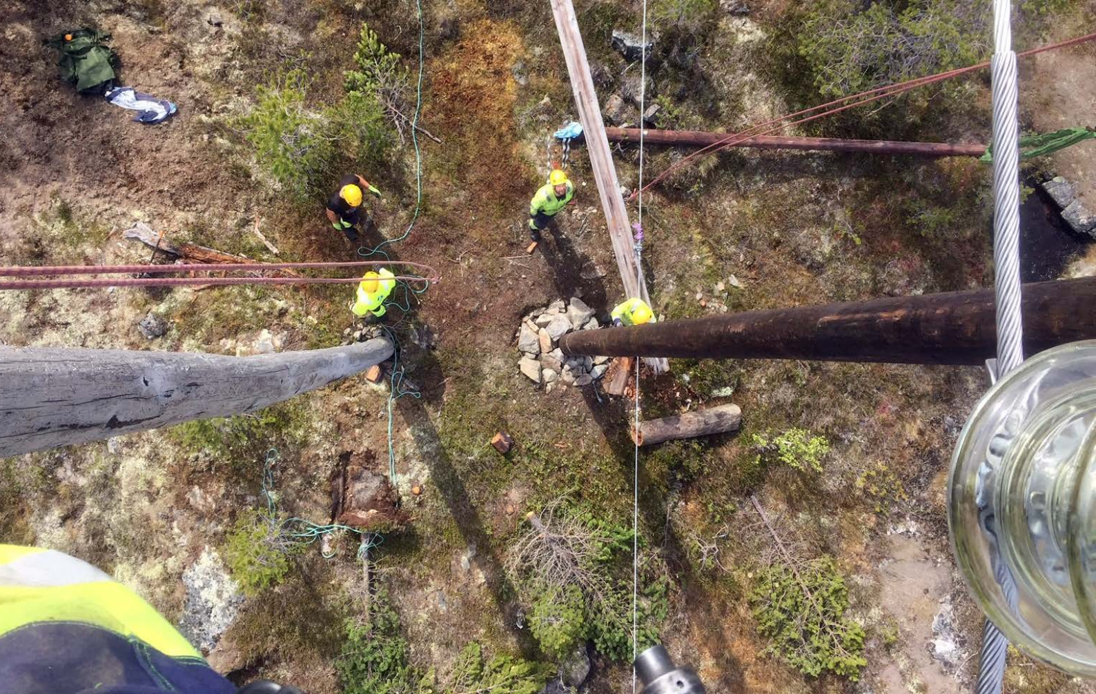
Skifte av høyspentstolpe sett i fugleperspektiv
