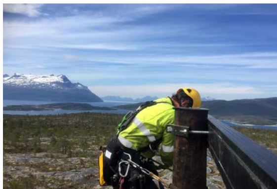
Skifte av travers på høyspentlinje
