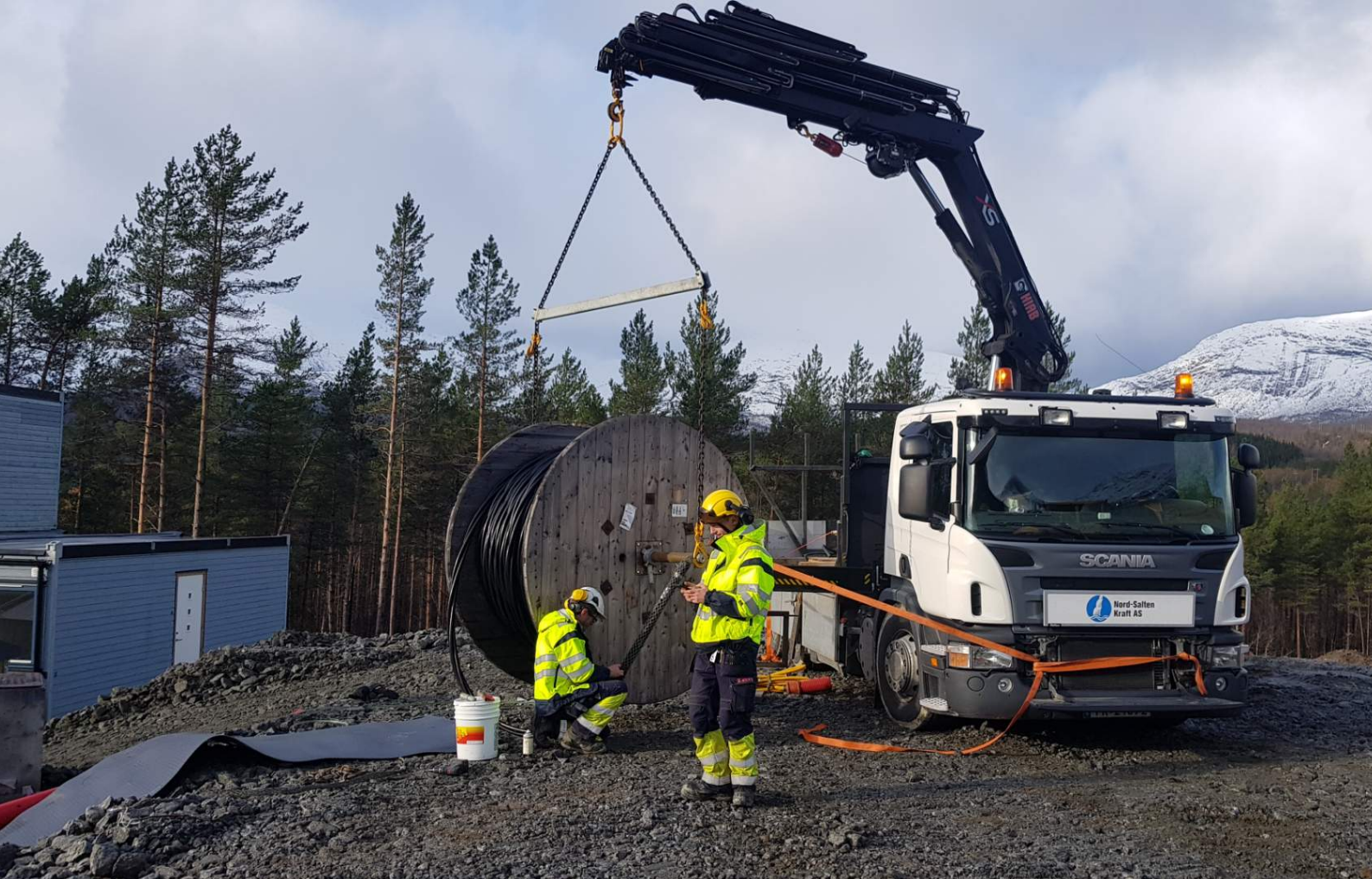
Montører fra NSK legger strømkabel til nettstasjon som skal forsyne nye Kobbvatnet transformatorstasjon (Statnetts anlegg) med strøm.
