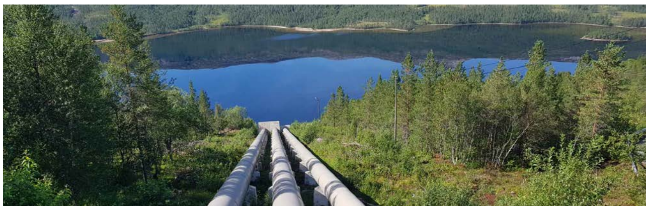
Rørgater til Rekvatn kraftstasjon
