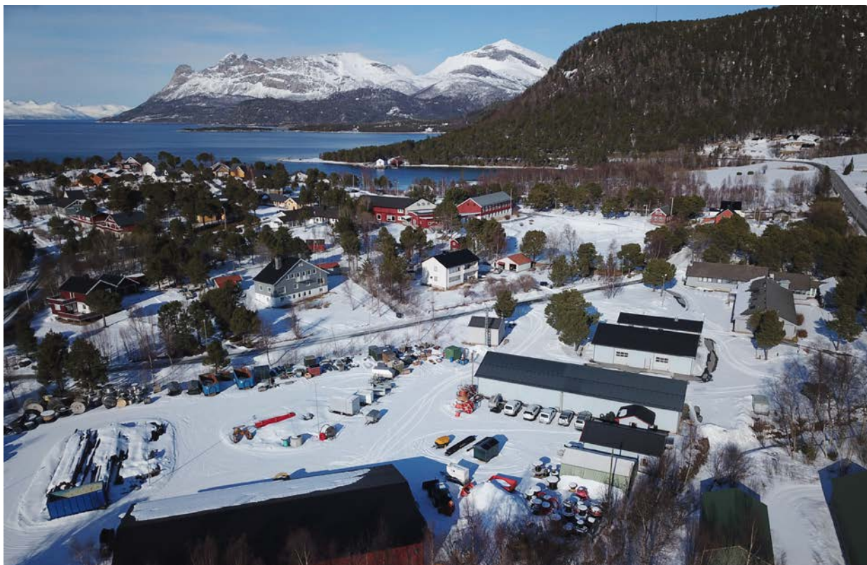
Nord-Salten Krafts lokaler på Ulvsvåg
