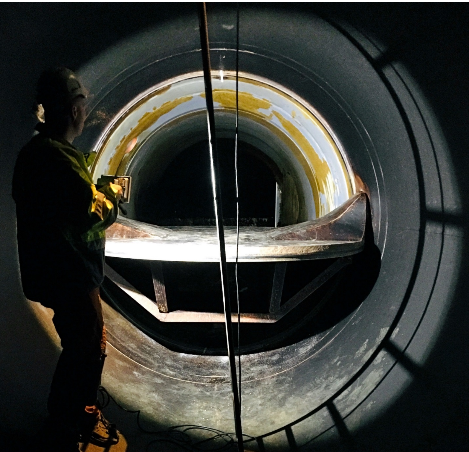
Inspeksjon av hovedventil til Sagfossen kraftverk
