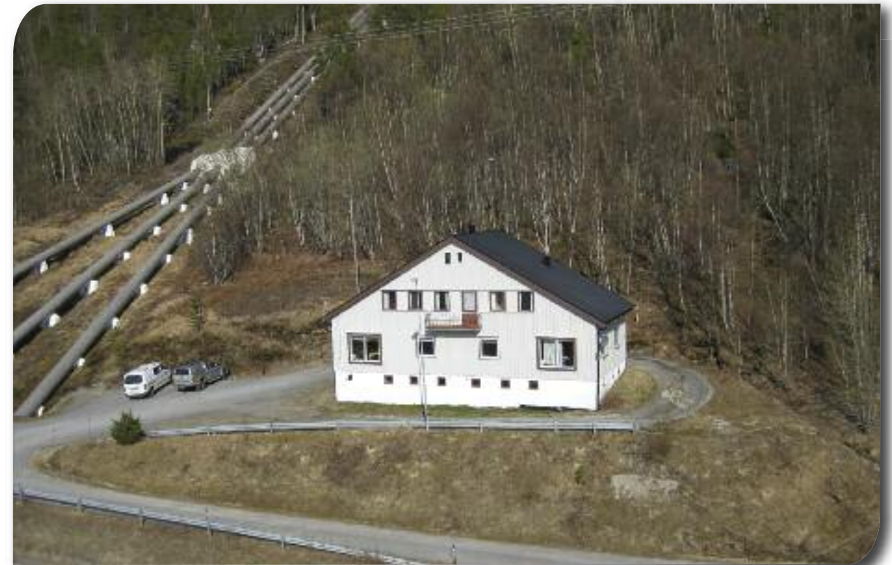
NSKs administrasjonsbygg ved rørgata til Rekvatn kraftstasjon.
