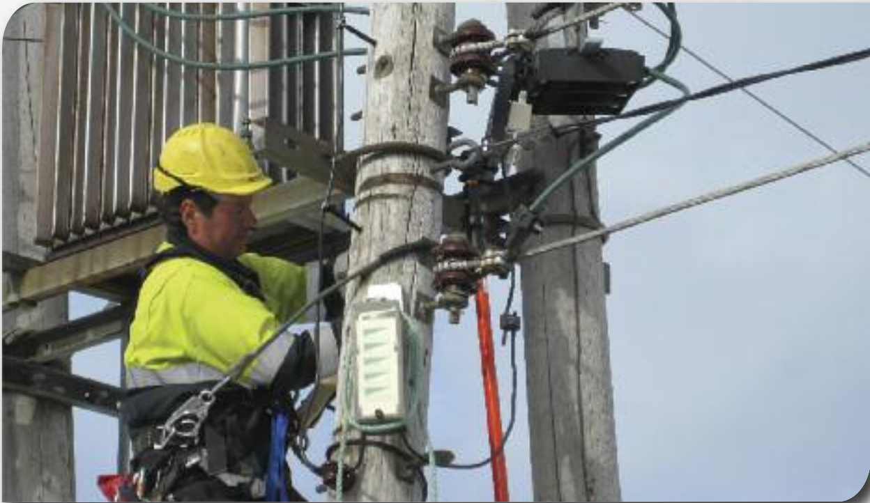
Gamle nettstasjoner skiftes ut for å bedre driftssikkerheten i nettet og sikkerheten til NSKs montører.
