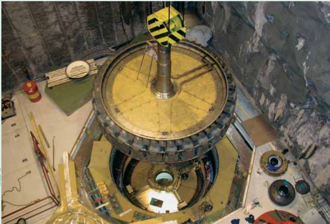
Reparasjon Sagfossen kraftverk.
