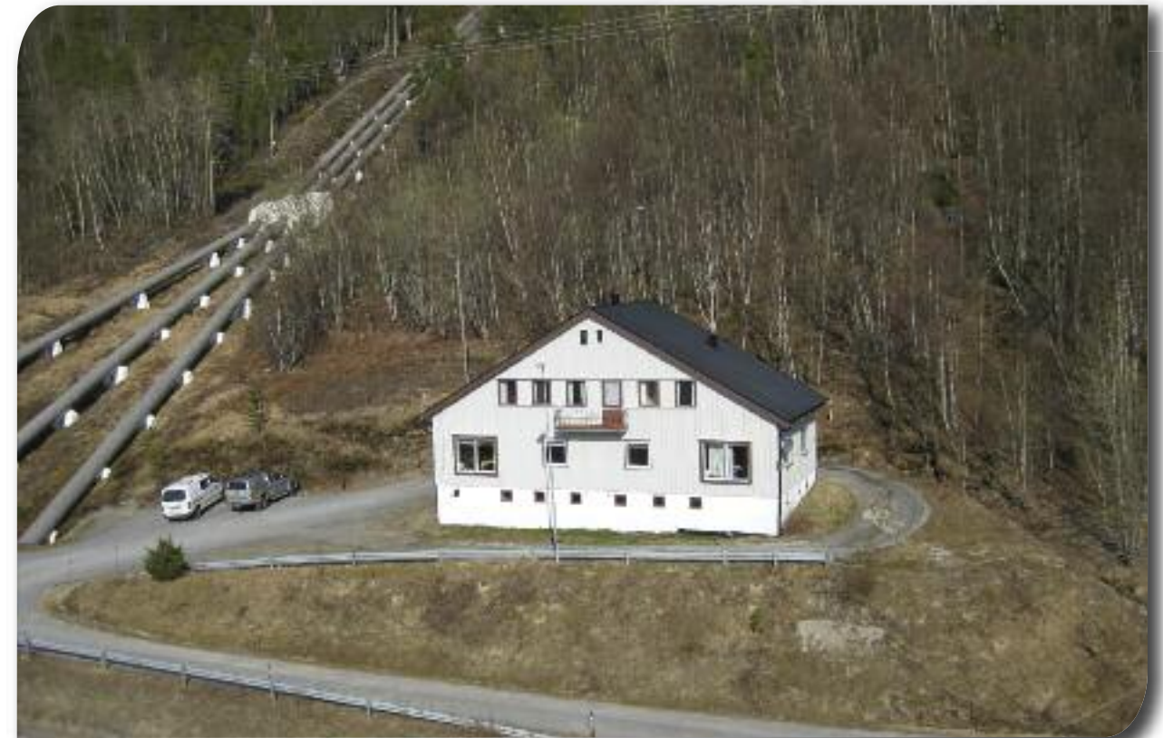
NSKs administrasjonsbygg ved rørgata til Rekvatn kraftstasjon.
